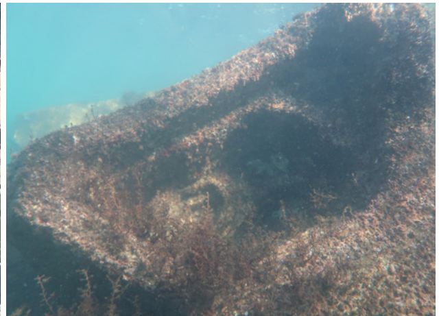
SITE 2: Las piezas Coastalock encajan entre sí para proporcionar una mayor estabilidad al revestimiento de escollera en talud y crear oportunidades de mejora ecológica mediante la creación de diversos hábitats marinos, tanto en zonas intermareales como sumergidas, gracias a las diferentes orientaciones que se pueden adoptar para la pieza durante su instalación.
