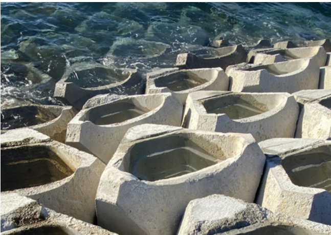
SITE 2: Las piezas Coastalock encajan entre sí para proporcionar una mayor estabilidad al revestimiento de escollera en talud y crear oportunidades de mejora ecológica mediante la creación de diversos hábitats marinos, tanto en zonas intermareales como sumergidas, gracias a las diferentes orientaciones que se pueden adoptar para la pieza durante su instalación.
