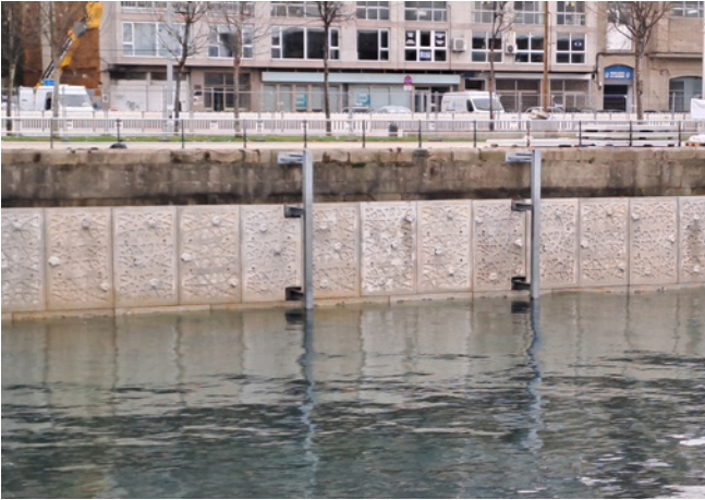
SITE 1: Instalación de los primeros paneles biopotenciadores tipo Mangrove de ECONcrete en el muelle de A Laxe, junto al observatorio submarino "Nautilus".
